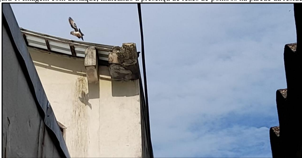
Figura 1: Imagem com destaque, indicando a presença de fezes de pombos na parede da residência
