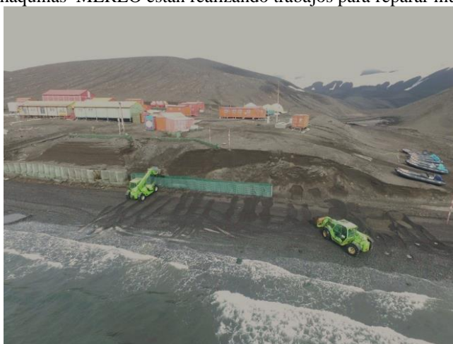
Figura 2. Foto donde las maquinas MERLO estan realizando trabajos para reparar muro de contencion principal.
